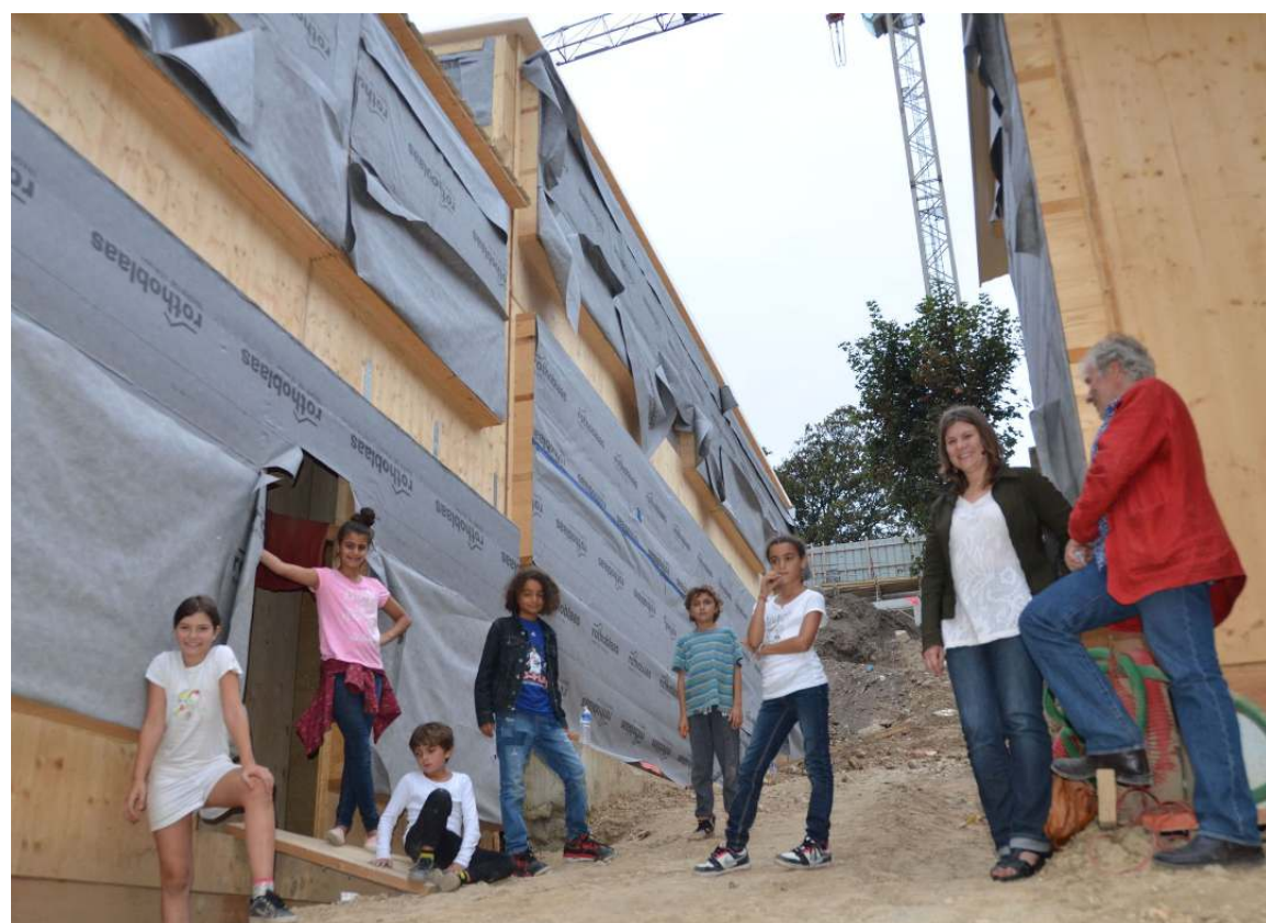
Ivry-sur-Seine, le 4 septembre. Plusieurs programmes immobiliers n'avaient jamais vu le jour sur ce terrain à cause du sol incliné à 8°. Du coup, des maisons sur pilotis à deux ou trois étages seront construites. (LP/L.Mé.)
