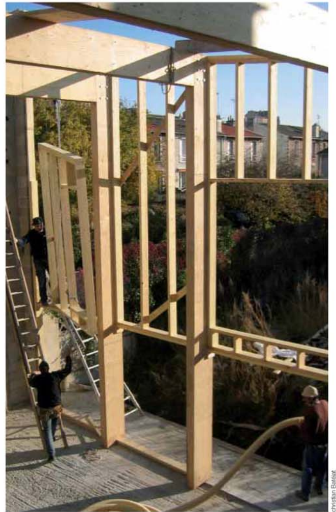
Atelier 15 participe tous les ans à la construction d'au moins deux maisons individuelles en bois.
